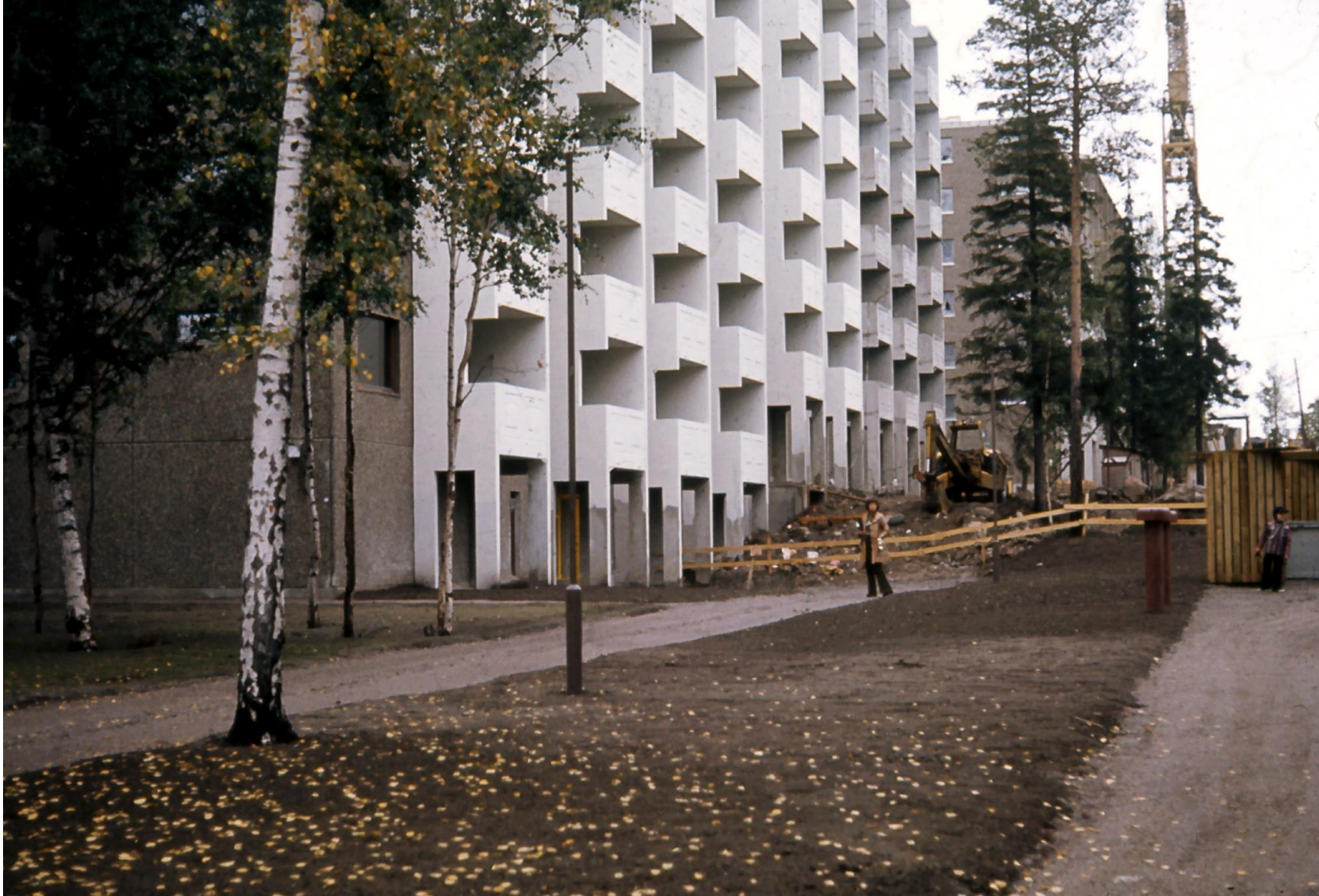
Kohta päästään muuttamaan! 1.9.1973 (kuva Kai R. Lehtonen)
